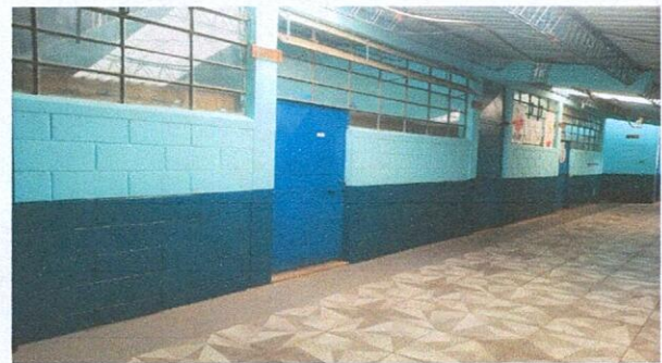
Foto 4: Cambio de piso en corredor
