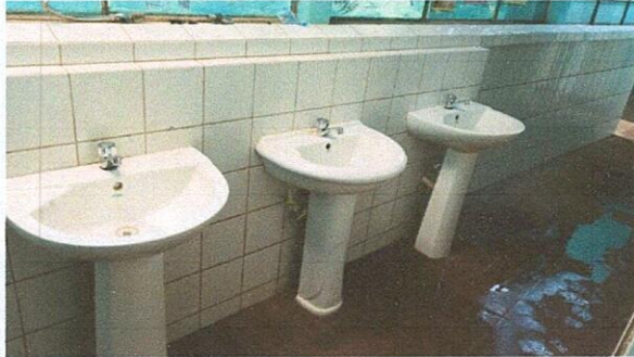
Foto1: Mantenimiento y cambio de llave de lavamanos
