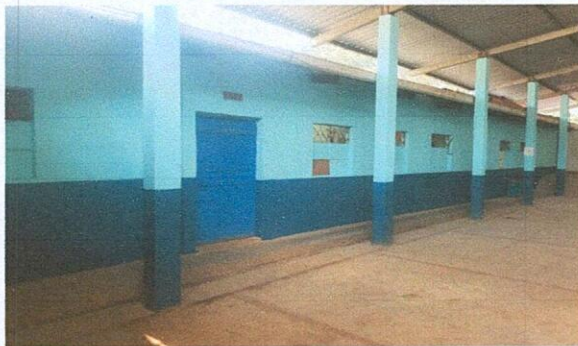
Foto 5: Renovación de canales
